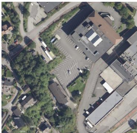
(Flyfoto av eiendommen)
